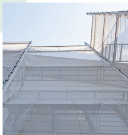
大規模改修工事
