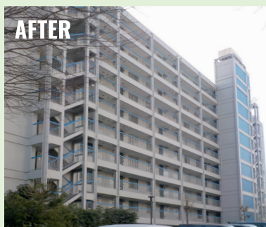
所沢コーポラス 690戸・3～11階建・全10棟
