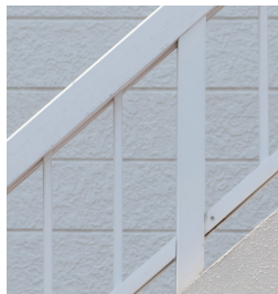
鉄部塗装工事
