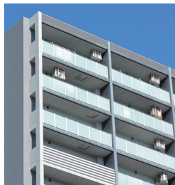
新築塗装工事
